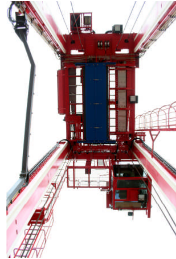
Blick vom Spreader nach oben auf die Unterseite der Maschinenbühne. Rechts zu sehen: Kabelschere. Links: ein Aufstieg
