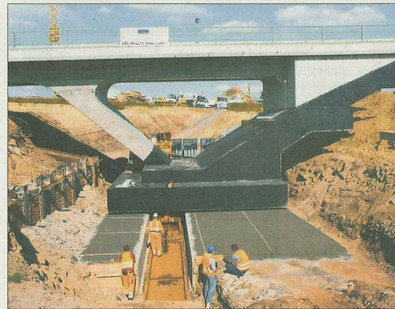
Gespanntheit auch bei den Bauleuten, die Brücke gleitet auf das eigens vorbereitete dünne Betonbett.
