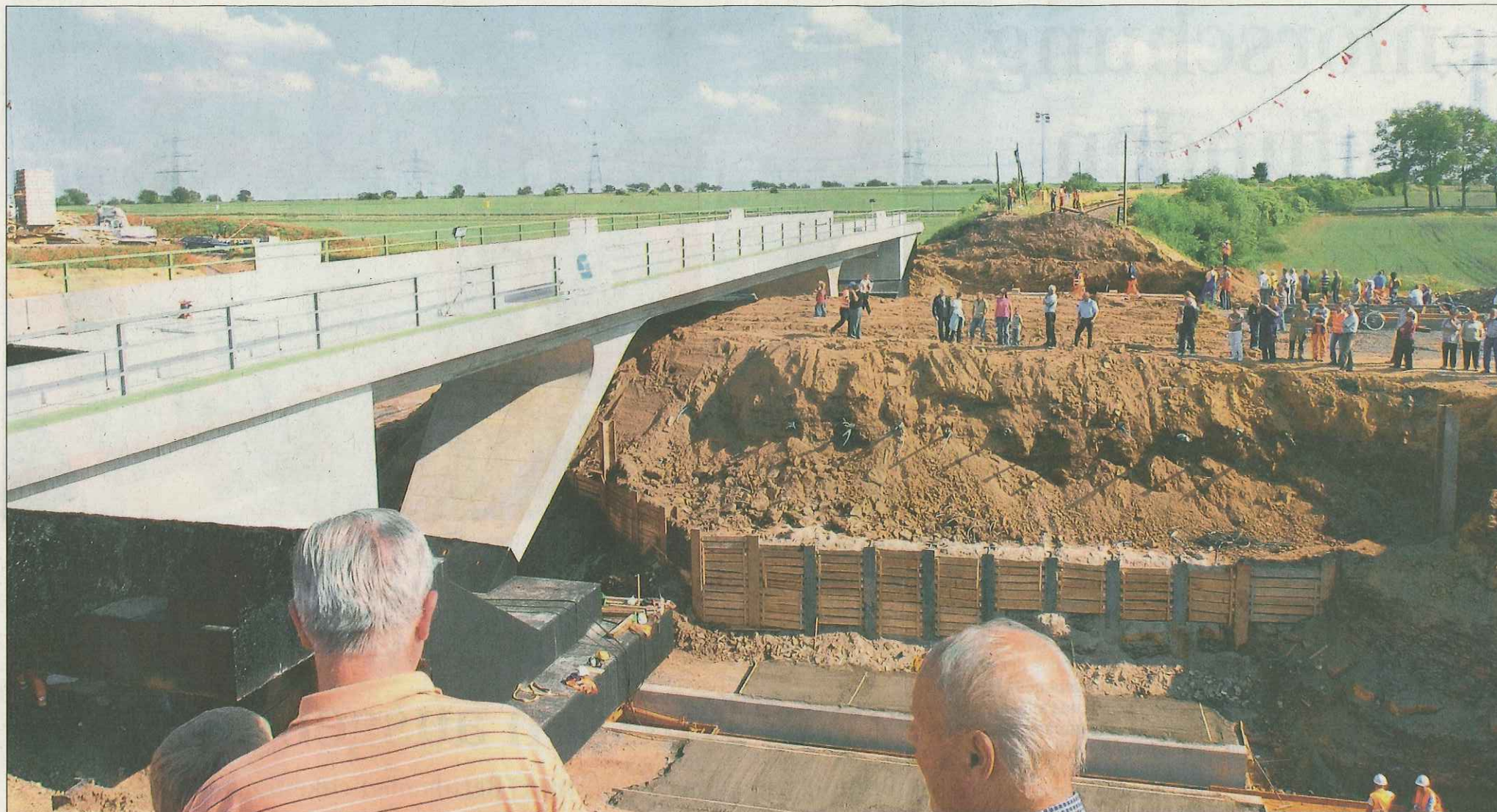
Eine Brücke fährt an ihren Bestimmungsort. An der im Bau befindlichen Ortsumfahrung B 180 n konnte gestern das 70 Meter lange und 3 500 Tonnen schwere Bauwerk in den
