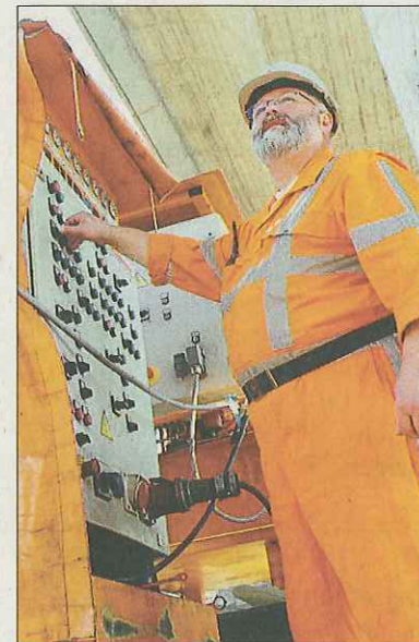
Kurt Schiller öffnet die Ventile zu den Stahlflaschen mit Stickstoff.
