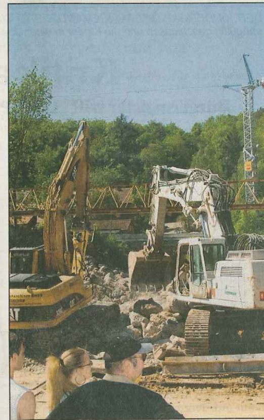
UNERWARTETEN WIDERSTAND leistete die alte Brücke den Abrissbaggern. Foto: msch
