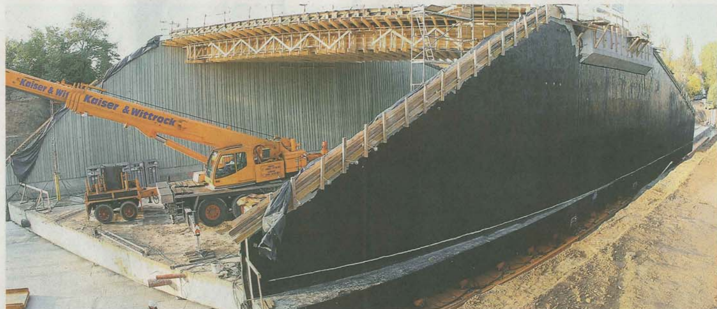
Eine Brücke geht auf Reisen: 70 Meter weit wird die neue Konstruktion in die Achse der Bahnstrecke geschoben. Gegründet ist sie auf einer Bodenplatte, die eine Fläche von 1000 Quadratmetern und eine Stärke von 1,40 Meter besitzt. Fotos: André Kempner
