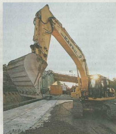
Tempo: Gleich nach der Brücke wird eine Erdrampe angelegt, auf der Laster Füllmaterial transportieren sollen.
