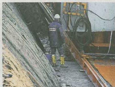
Millimeterarbeit: Spezialstahlschienen und Stickstoffkissen lassen ein Reisetempo von 30 Zentimetern pro Minute zu.
