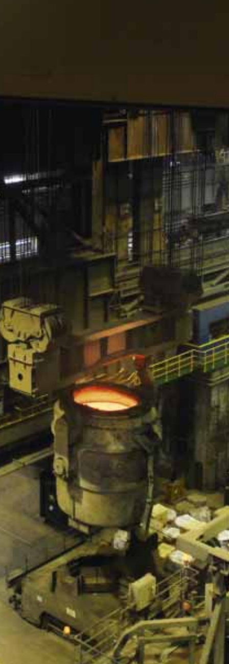
Eine Gießpfanne versorgt die HKM-Stranggießanlage ständig mit Nachschub.
