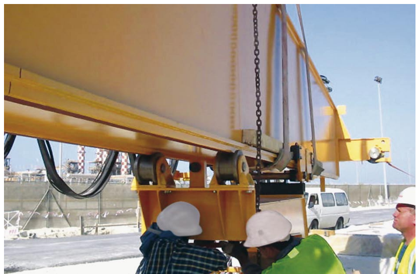
Siemens Al Ezzel Kraftwerk, Bahrain
