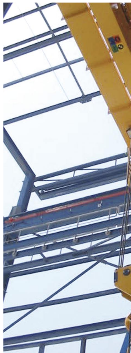
Al Ezzel Kraftwerk, Bahrain
